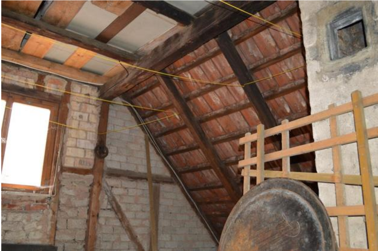
Blick auf den Boden / Kaltdach
