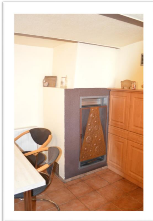
Alternativer Holz/Kohleofen in der Küche/Wärmeschacht bis zum Wohnzimmer
